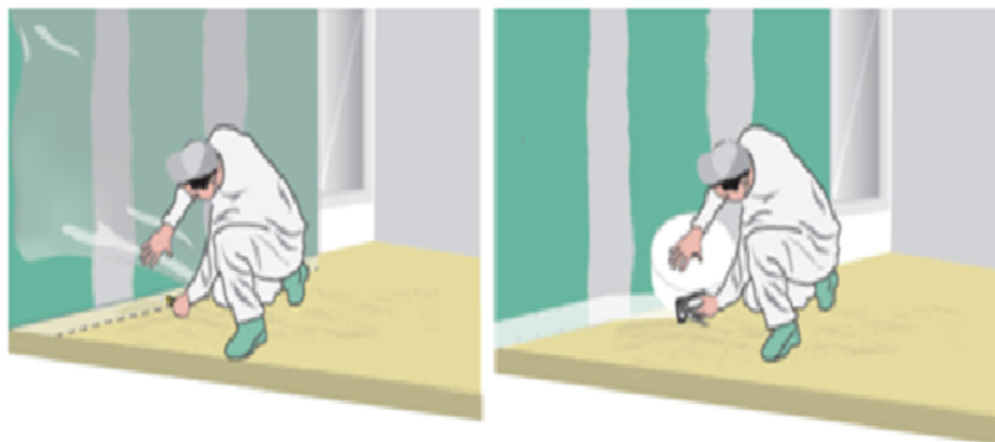
Figure 2 : Réalisation de la désolidarisation périphérique
